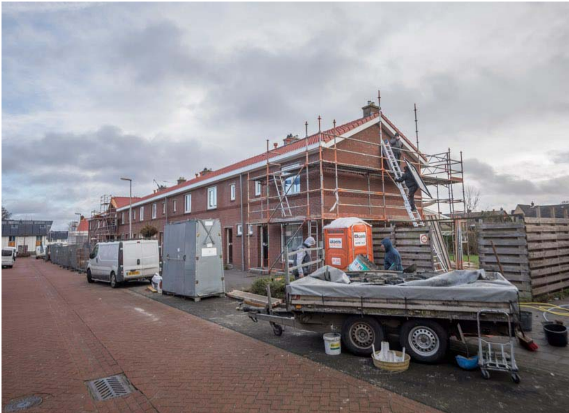
In de Crocusstraat worden de eerste woningen gemoderniseerd. FOTO LUC LODDER
